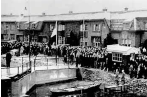
foto: De officiële opening van de nieuwe, betonnen steiger voor de schepen van de Alkmaar Packet in de zomer van 1947. De oude, houten steiger was in de hongervinter gesloopt en opgestookt.
